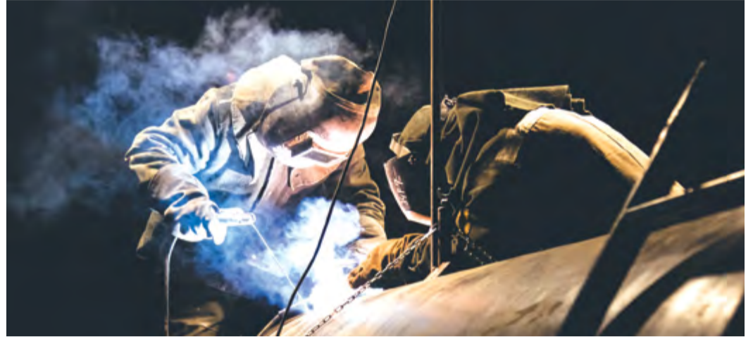
Огневые работы в зоне ответственности Парабельского ЛПУМГ
